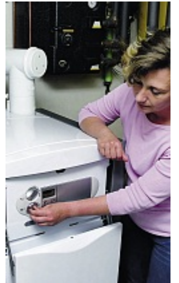
Brennwertkessel sind der Stand der Technik bei Öl- und Gasheizungen – ideal für die Umwelt ist die Kombination mit Solarthermie. Foto: dpa
