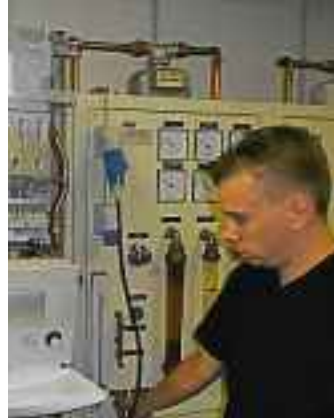
Beim Heizungscheck wird klar, ob der energetische Sollzustand erreicht wird.
